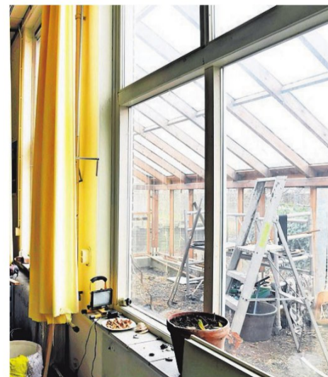
▲ Tegen de buitenwand zien we een serre in aanbouw.
