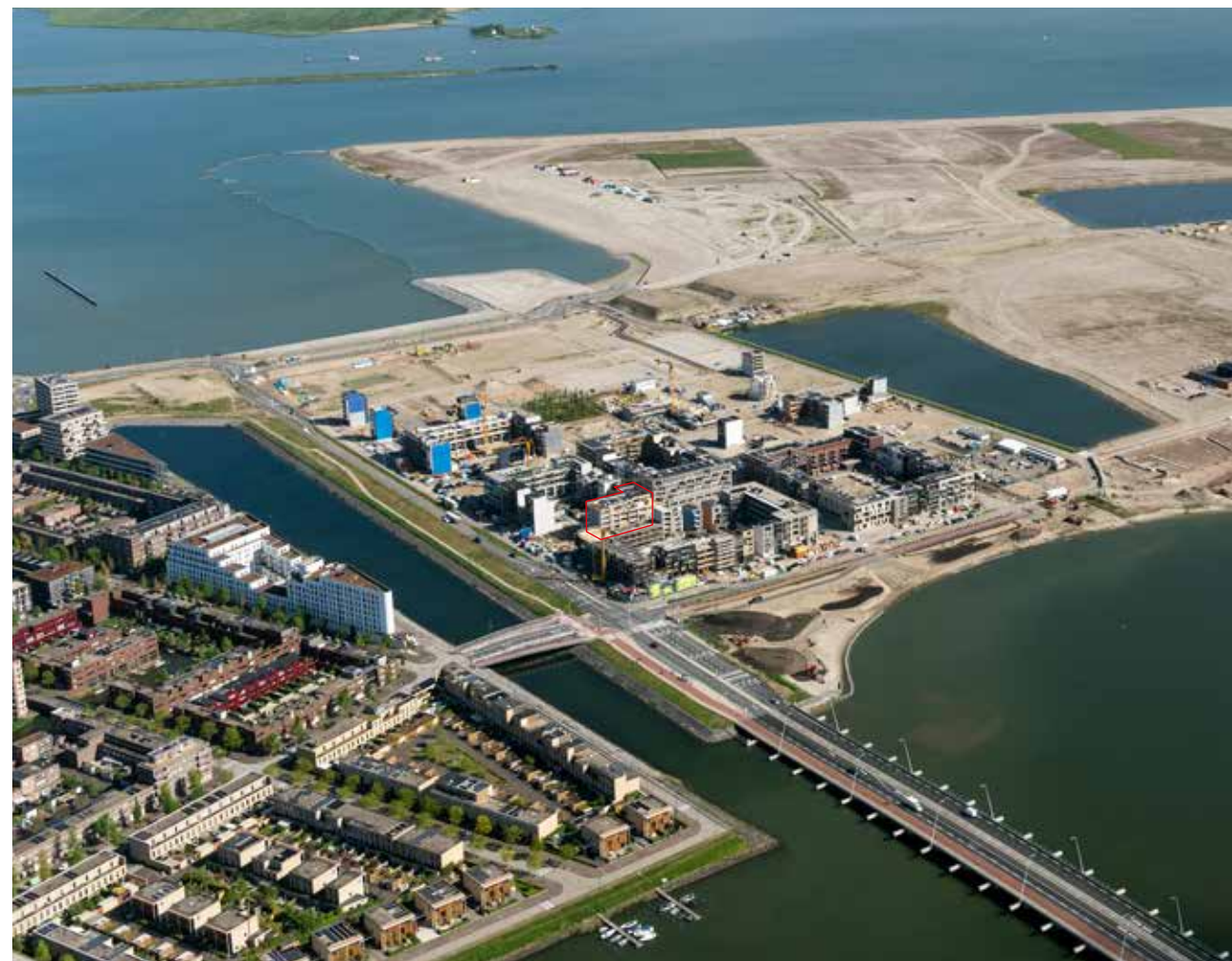
Centrumeiland op IJburg in aanbouw. Wooncoöperatie De Warren bevindt zich op een van de eerste bebouwde kavels.
