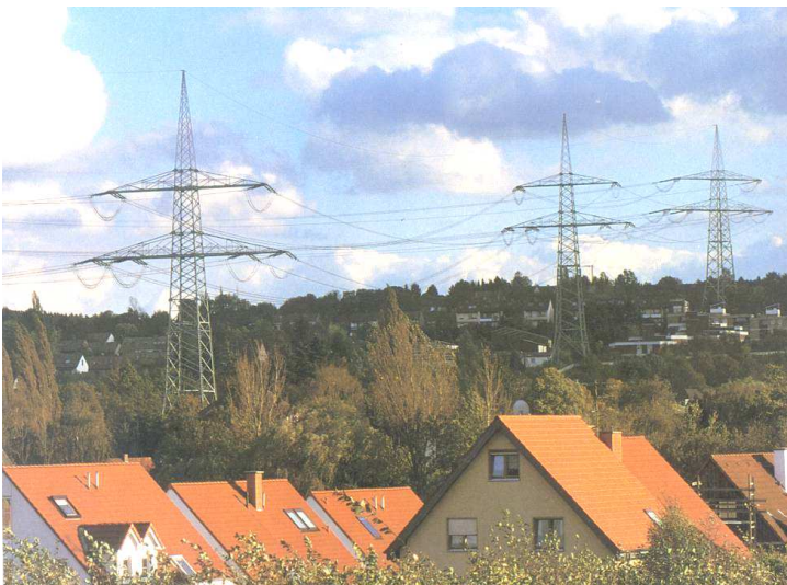
“Gevaarlijk” wonen door straling elektra leidingen
