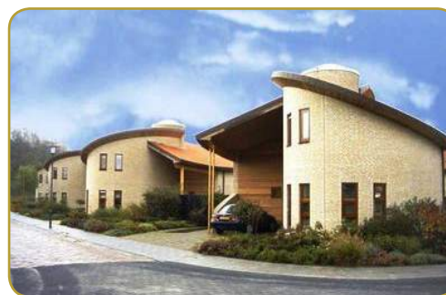
5 Woningen, Rijen Opdrachtgever: Van Laarhoven Combi bouw
